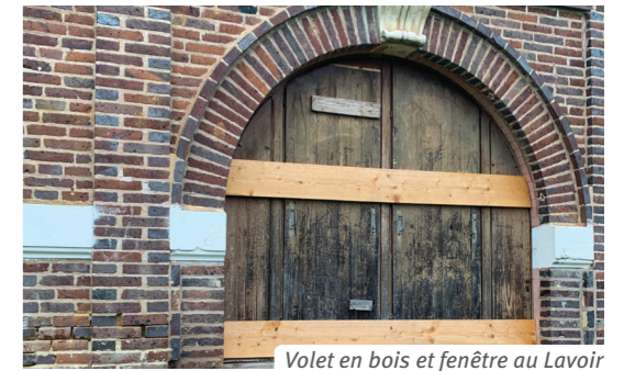
Volet en bois et fenêtre au Lavoir
